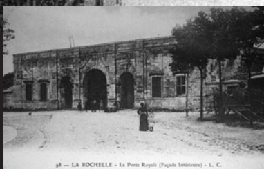
98 — LA ROCHELLE - La Porte Royale (Façade Intérieure) - L. C.
